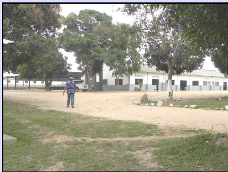
Vue sur la cour du C.I Kasangulu
